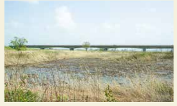
第1植生浄化池の鹿角市にあたる位置から望む秋田南大橋
