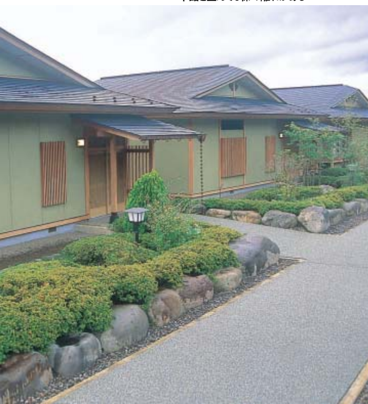
本館と並んで3棟の離れがある
