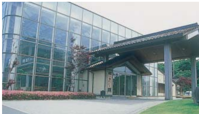
斬新な建築デザインが印象的ないちゑの外観
