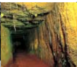
排水・運搬・通路用に掘られた疎水坑道
