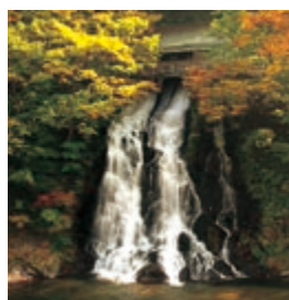
瀬見発電所の流水が滝のように小国川に注ぐ
